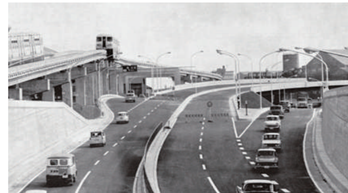
オリンピックに向けたインフラ整備（首都高とモノレール）
