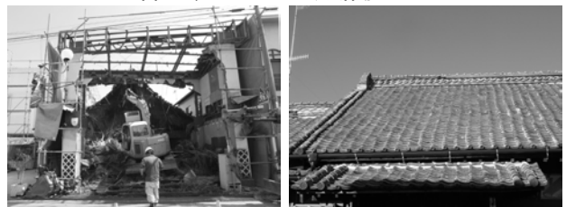
写真1 解体中のS邸
