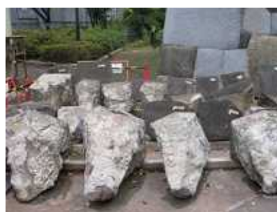
左: 石垣修復後 右: 整理中の石
